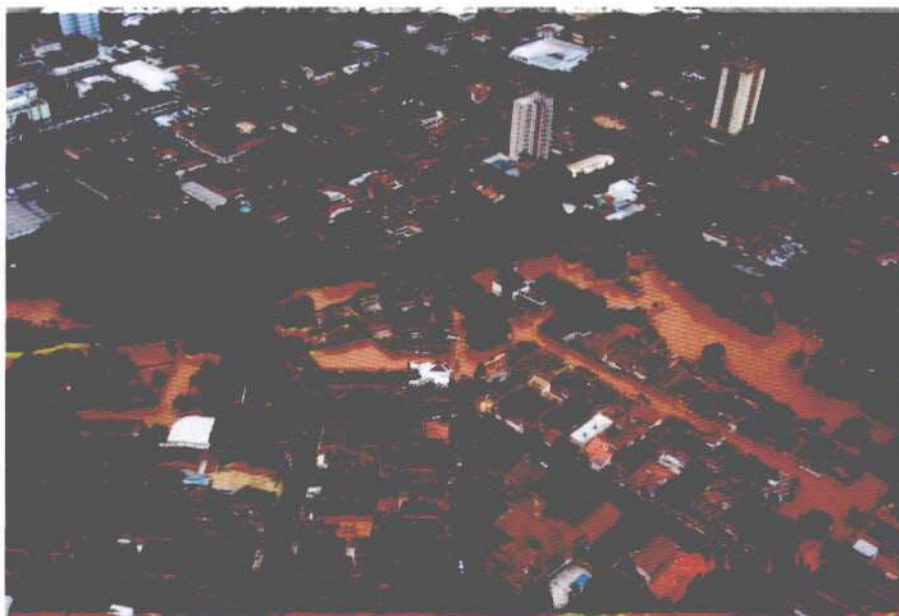
FIGURA 5- 5: VISTA AÉREA DA ÁREA DA ETA DURANTE INUNDAÇÃO
