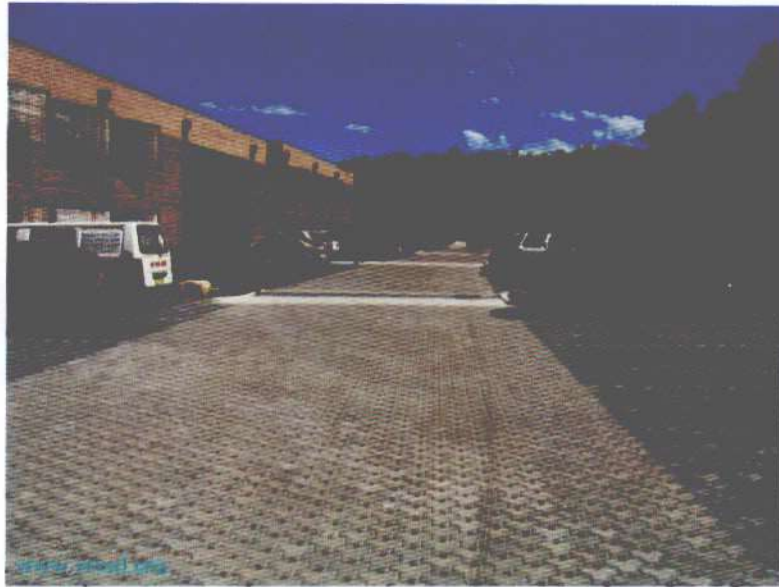
FIGURA 15- 9: PAVIMENTO PERMEÁVEL – WSUD
