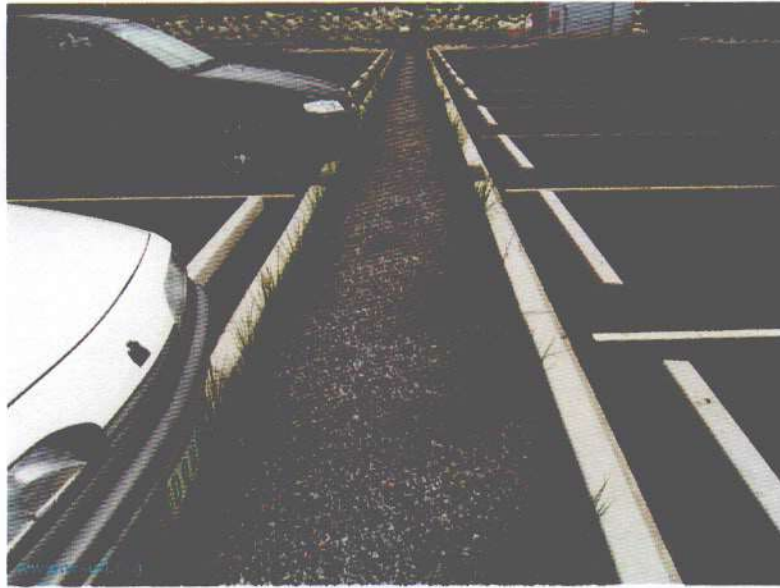
FIGURA 15- 3: TRINCHEIRA DE INFILTRAÇÃO EM ESTACIONAMENTO – WSUD 21
