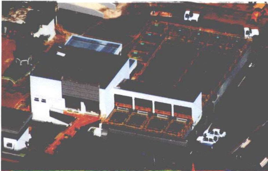
FIGURA 5- 4: VISTA AÉREA DA ETA "OSVALDO PEREIRA DE BARROS"
