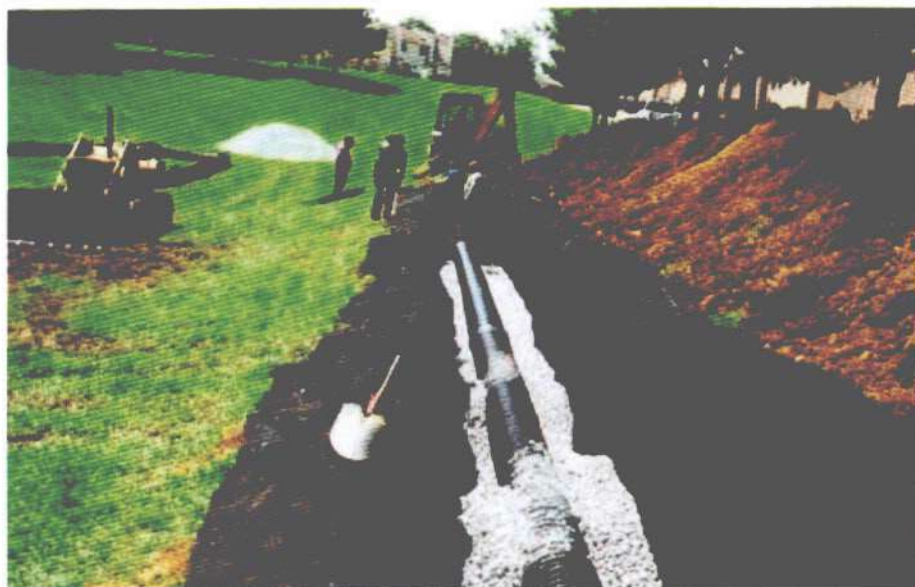
FIGURA 15- 2: CONSTRUÇÃO DE TRINCHEIRA DE INFILTRAÇÃO
