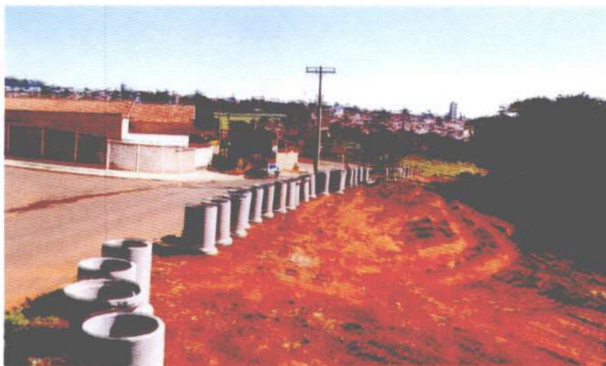
FIGURA 6- 4: INSTALAÇÃO DE INTERCEPTOR DO CÓRREGO CACHOEIRINHA
