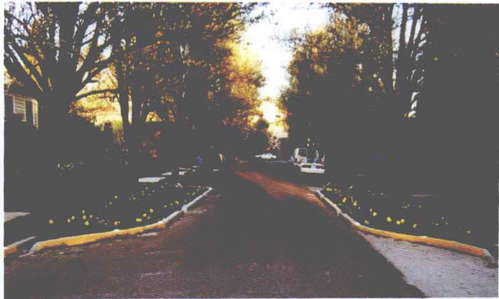
FIGURA 15- 7: TRINCEIRAS OU POÇOS DE INFILTRAÇÃO NA VIA PÚBLICA- CIDADE DE SEATTLE- EUA
