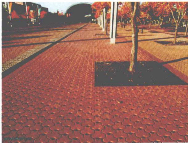
FIGURA 15- 10: PAVIMENTO PERMEÁVEL – WSUD
